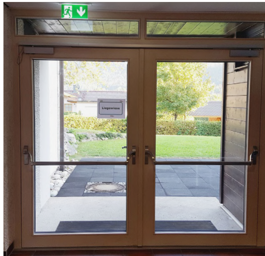
Abb. 18 Notausgang mit Panikstange und Kennzeichnungen
