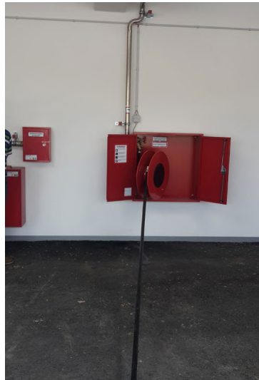
Abb. 54 Verwendung eines Wandhydranten zur Entstehungsbrand-bekämpfung
