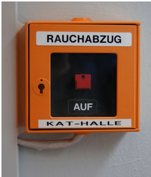
Abb. 40 Auslöseeinrichtung Rauchabzug
