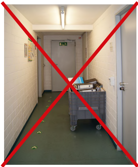
Abb. 17 Unzulässige Lagerung im Flucht- und Rettungsweg
