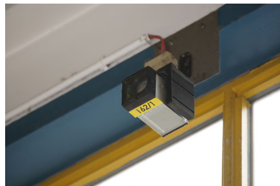
Abb. 35 Lichtschraken-Rauchmelder
